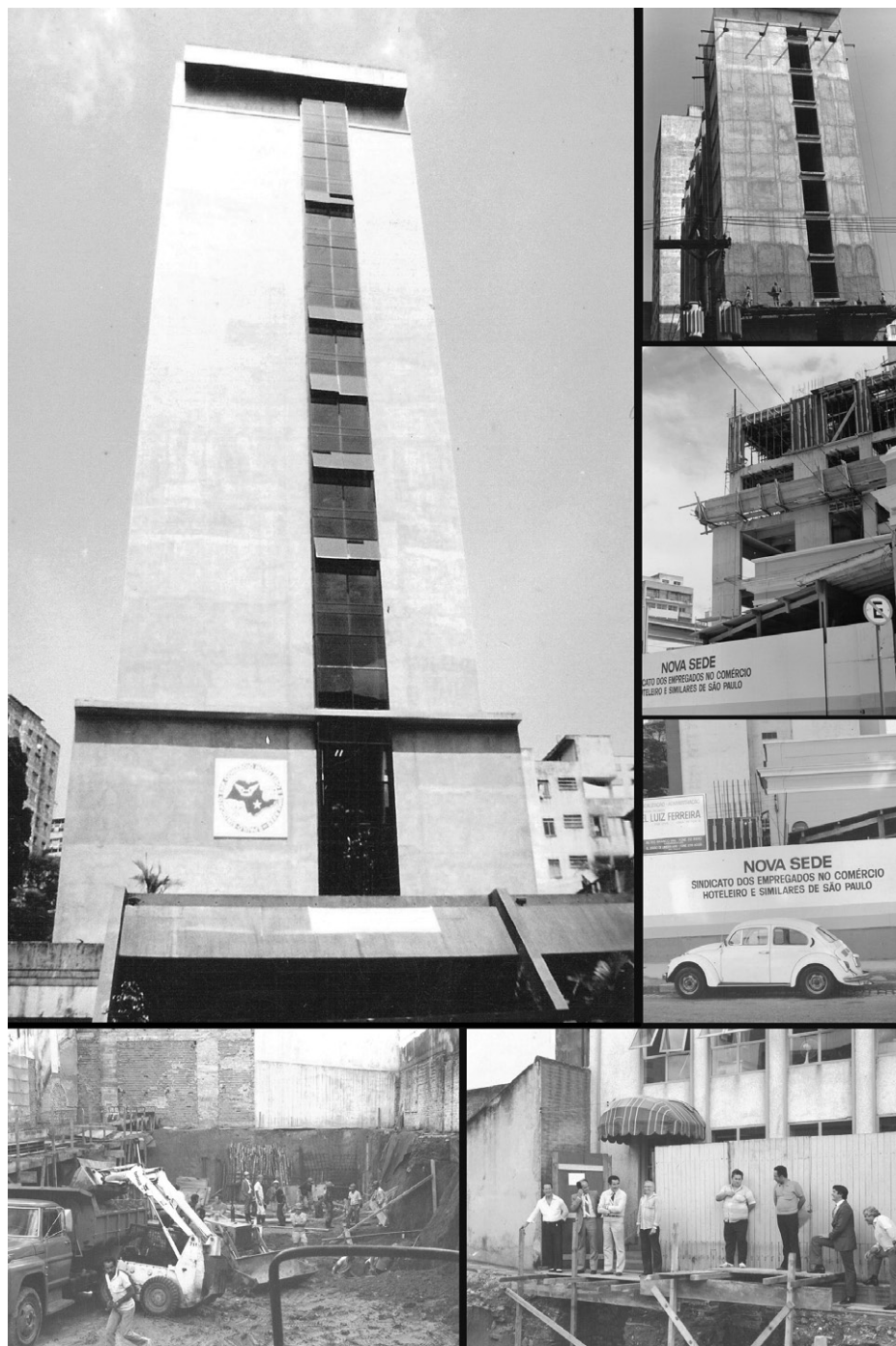
Construção da nova sede
